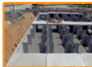
アクアポンドS型 (プレキャスト雨水貯水槽)
