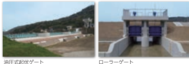
油圧式起伏ゲート
