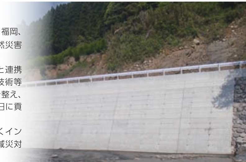
星野川筋河川改良復旧工事（納入製品 パワーロックII）
