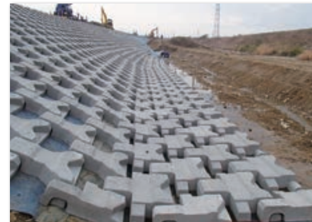
広川護岸工事（納入製品 CV絆）
