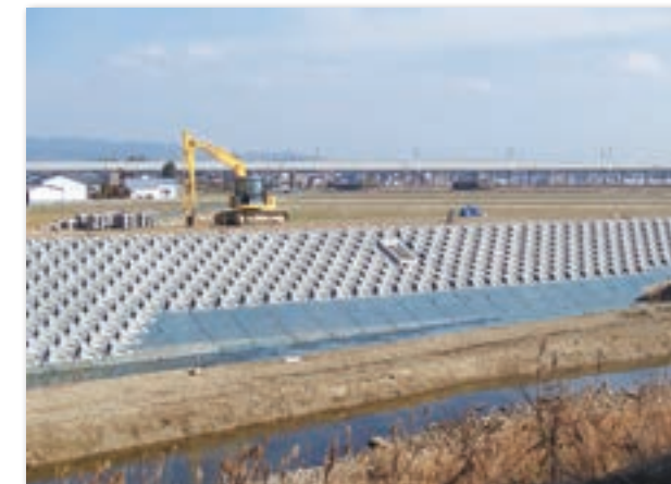
広川護岸工事（納入製品 CV絆）
