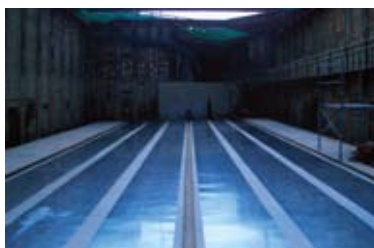
1 滑走面養生工
