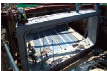
4 ボックスカルバート組立状況
