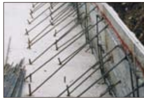
2 4ヶ所のサポート筋で固定する。
