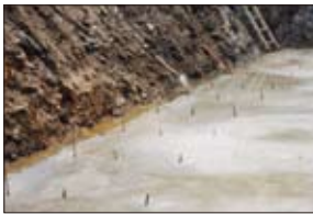
1 基礎に溶接用鉄筋を埋めておく。
