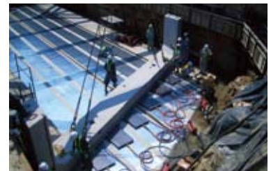
3 荷降ろし状況
