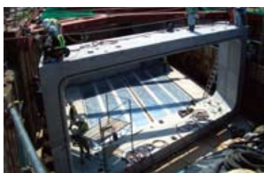
4 ボックスカルバート組立状況
