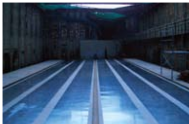
1 滑走面養生工
