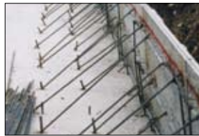
2 4ヶ所のサポート筋で固定する。
