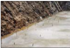
1 基礎に溶接用鉄筋を埋めておく。
