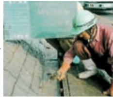
3 アンカー打設
