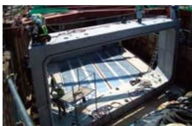
4 ボックスカルバート組立状況
