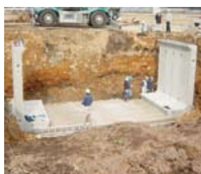
側壁部材を設置する。
