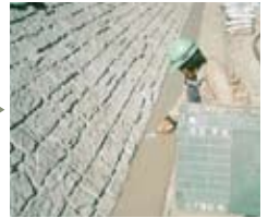
5 埋戻コンクリート
