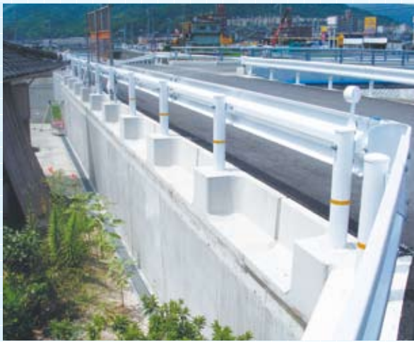
3. 補強土壁工上部に施工
