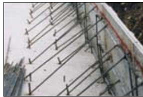
2 4ヶ所のサポート筋で固定する。
