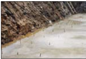
1 基礎に溶接用鉄筋を埋めておく。
