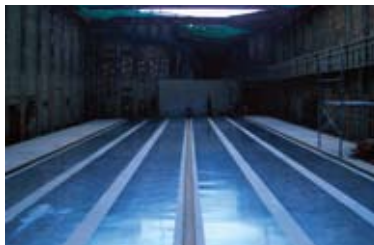
1 滑走面養生工
