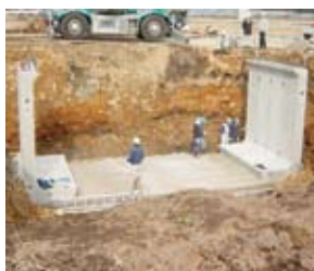
側壁部材を設置する。
