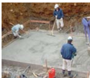
基礎砕石敷設後、均しコンクリートを打設する。
