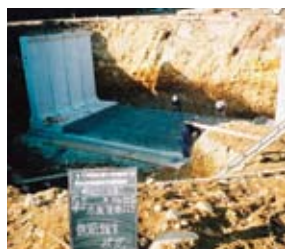
基礎砕石敷設後、均しコンクリートを打設する
