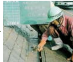
3 アンカー打設
