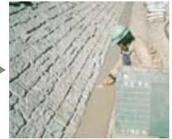
5 埋戻コンクリート
