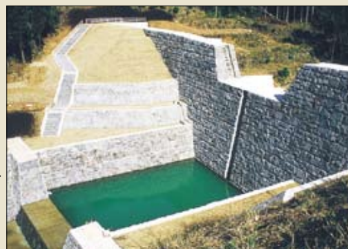
▲阿茂瀬川火山砂防工事
