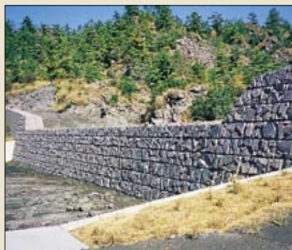
▲民有林直轄治山工事
