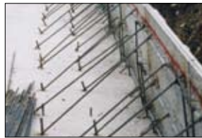
2 4ヶ所のサポート筋で固定する。
