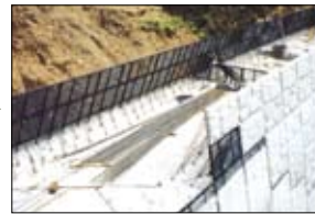
3 内側にて作業をし、パネルを組み立てていく。
