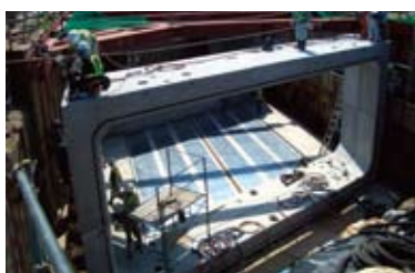
4 ボックスカルバート組立状況
