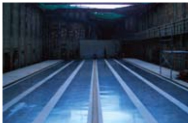
1 滑走面養生工
