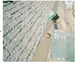
5 埋戻コンクリート
