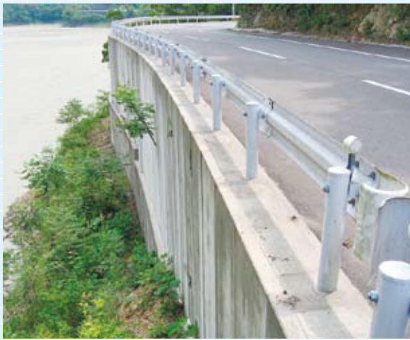
3. 補強土壁工上部に施工
