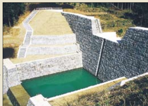
▲阿茂瀬川火山砂防工事
