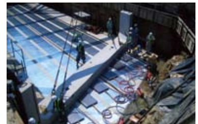
3 荷降ろし状況
