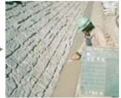
5 埋戻コンクリート
