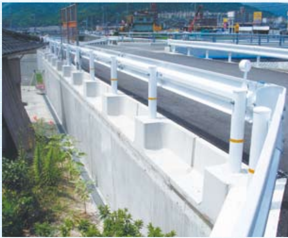
3. 補強土壁工上部に施工
