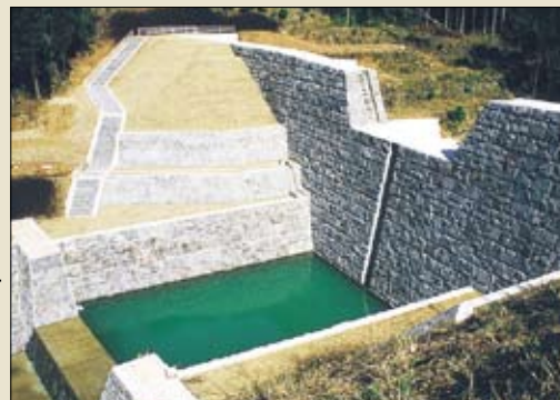
▲阿茂瀬川火山砂防工事
