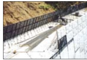
3 内側にて作業をし、パネルを組み立てていく。
