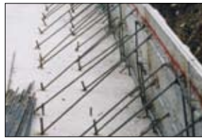
2 4ヶ所のサポート筋で固定する。
