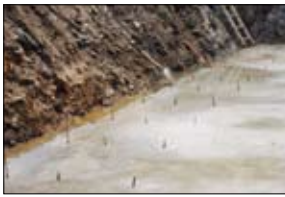
1 基礎に溶接用鉄筋を埋めておく。
