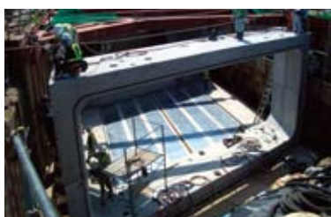
4 ボックスカルバート組立状況
