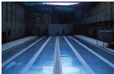
1 滑走面養生工
