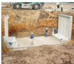
側壁部材を設置する。
