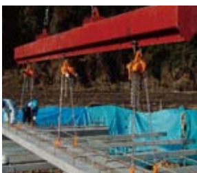
支保工を設置し頂版スラブを架設する。
