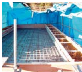
頂版部に配筋を行ない、頂版コンクリートを打設する。
