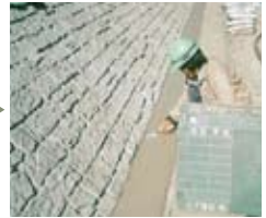
5 埋戻コンクリート
