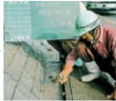
3 アンカー打設
