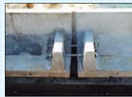
3 連結工 結合コンクリートは連結部に 充填します。
