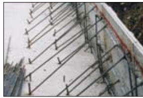
2 4ヶ所のサポート筋で固定する。
