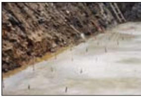
1 基礎に溶接用鉄筋を埋めておく。
