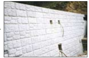
4 打設高は1.5m未満とする。(パネル1枚に4本のサポート筋の場合)
