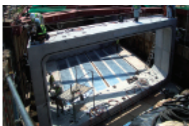
4 ボックスカルバート組立状況
