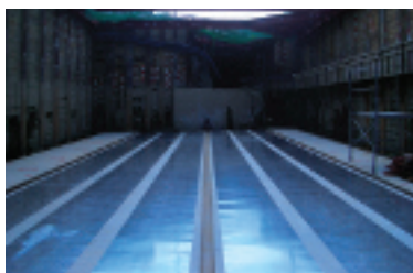
1 滑走面養生工
