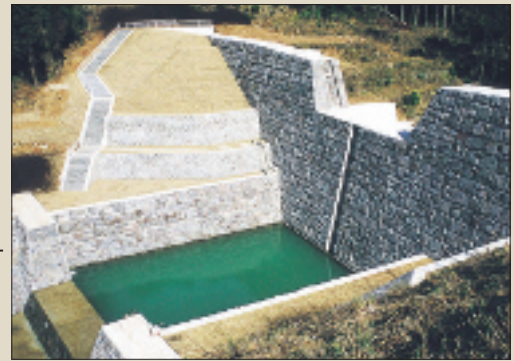
▲阿茂瀬川火山砂防工事
