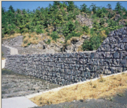
▲民有林直轄治山工事
