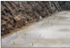
1 基礎に溶接用鉄筋を埋めておく。
