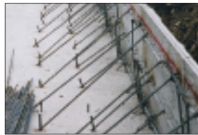
2 4ヶ所のサポート筋で固定する。
