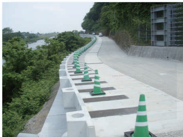
施主：岐阜県揖斐土木事務所 工事名：単県地方特定道路整備事業（緊急防災対策）藤橋池田線
